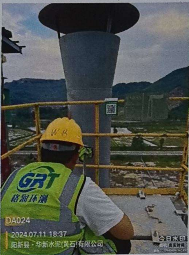
DA024 号排气筒水泥库顶采样口◎11
